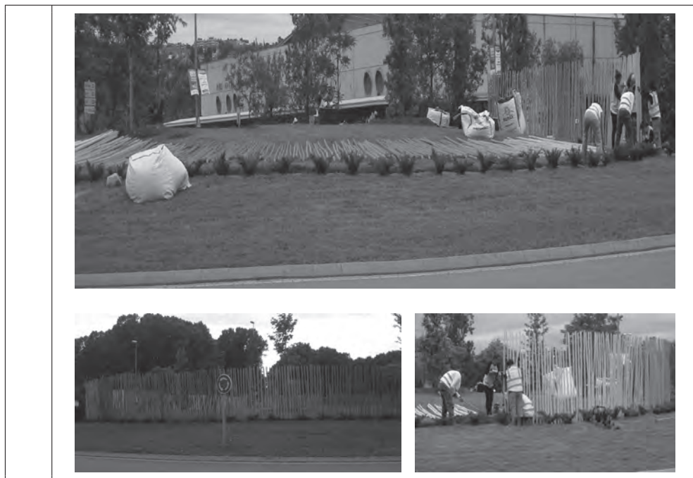
Taula 6. Observació del procés d'instal·lació de l'escultura de la rotonda.
